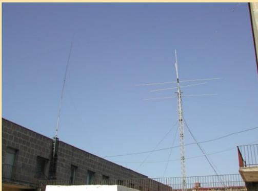
Antenne verticale 80, 40 m. quad 3 éléments
