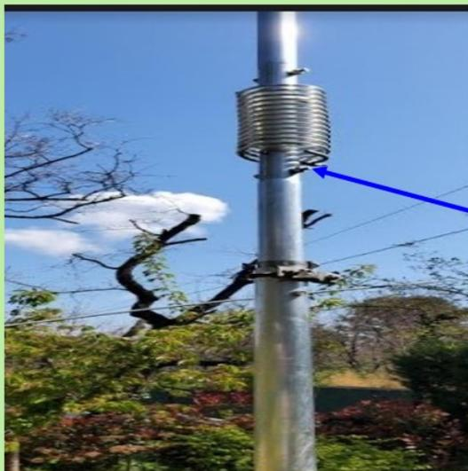
Les réglages de l'antenne avec un analyseur se font sur la hauteur de l'antenne et sur la longueur des radiaux
